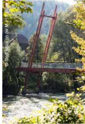
Die Hohenlimburgbrücke, die auch Teil des wunderbaren Altstadt-Rundwanderwegs rund um die Mur ist.
